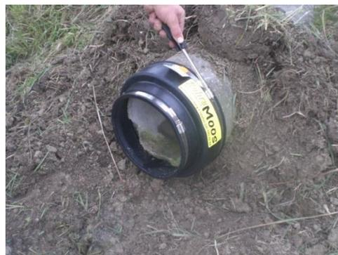
Spannband mit Schraubenzieher „rutschfest“ anziehen!
