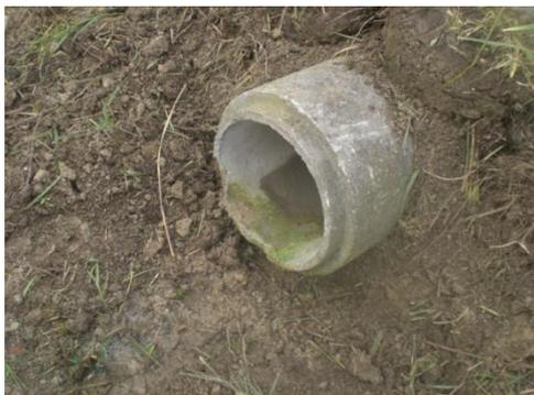
bestehendes Rohr genügend freilegen und sauber reinigen!
