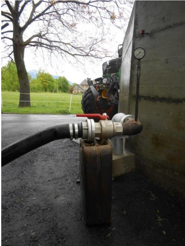
6.) Absperrhahn am Hydrant auf dem Feld montieren
