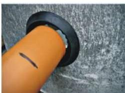
Mit einem Maßstab die Wandstärke messen und eine Markierung am Rohrende anbringen. Die Dichtung mit Gleitmittel (Flexseal weiß) einstreichen.
