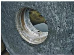
Die Kernbohrung mit einer geeigneter Bohrkronen in dem geforderten Durchmesser herstellen.
