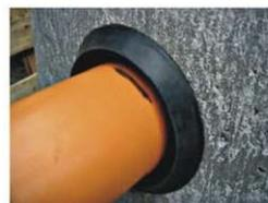
Das Rohr bis zur Markierung einschieben.
