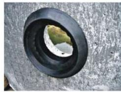
Die Dichtung bis zum Anschlag einpressen (ev. einfalten). Dabei kein Gleitmittel verwenden!
